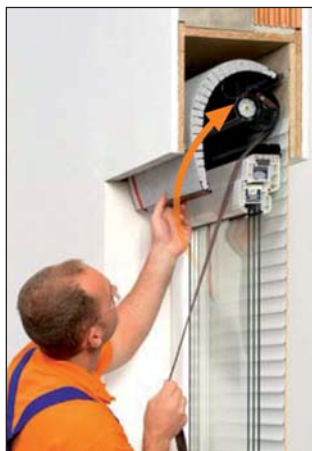
Termo-Rollladen einsetzen
