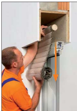
Alte Rollladen entfernen
